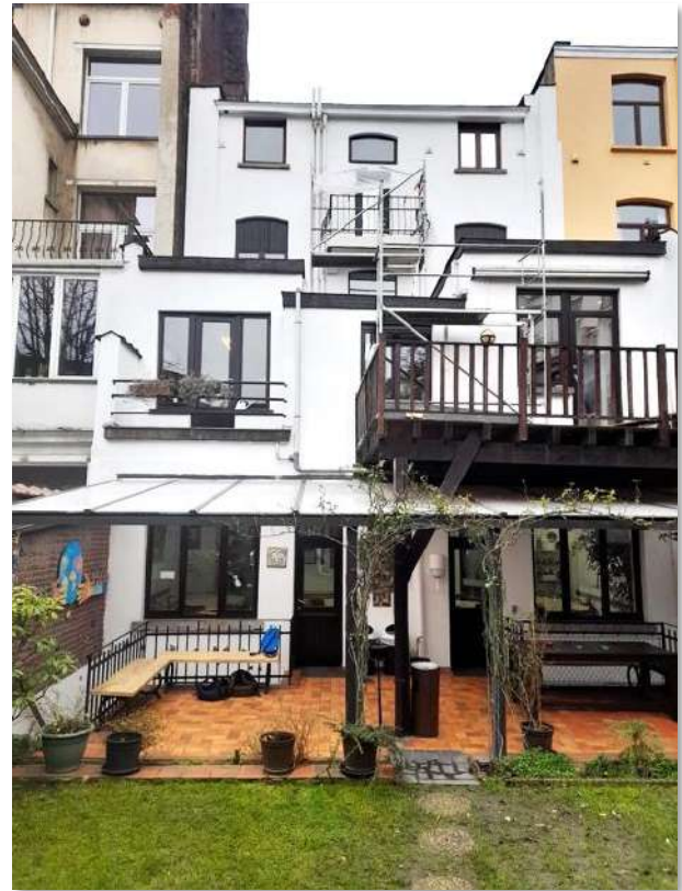
Des travaux de rénovation de notre façade arrière, indispensables en 2022
